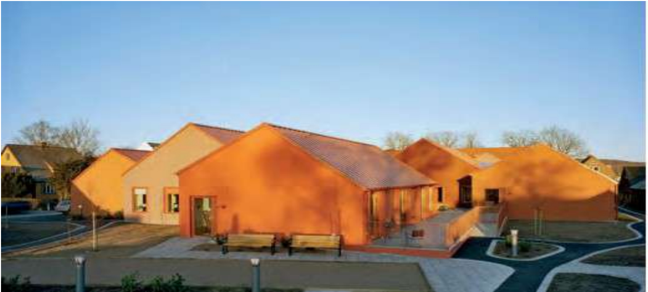
Norra Vram Nursing Home Billeshom, Svezia--MARGE ARKITEKTER
